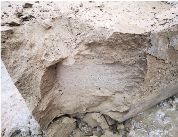
Bild 4: Fertiges Zement-Polyurethan-Gemisch mit RASCOHybrid HMS317
