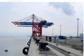
Jade-Weser-Port Deep-Sea Port Wilhelmshaven
